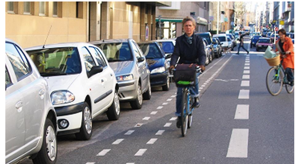
Bande cyclable avec espace tampon de 0,5 mètre
